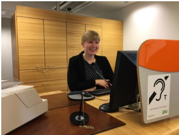
Kuva 28 Kiinteästi työpöytään asennettu palvelupistesilmukka (Lähde: QLU Oy)
